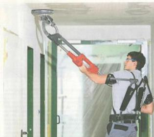
Trockenbauer mit Greif: Der Schleier vor Decken erleichtert das Erreichen der Arbeitshöhe.
