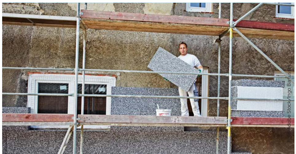
Gebäudesanierungen spielen bei der Bewältigung der Klimakrise eine bedeutende Rolle.
