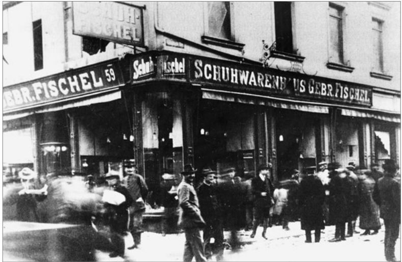
Zerstörte Schaufenster eines Schuhge- schäfts in der Bahnhofstraße Saarbrücken. 23
